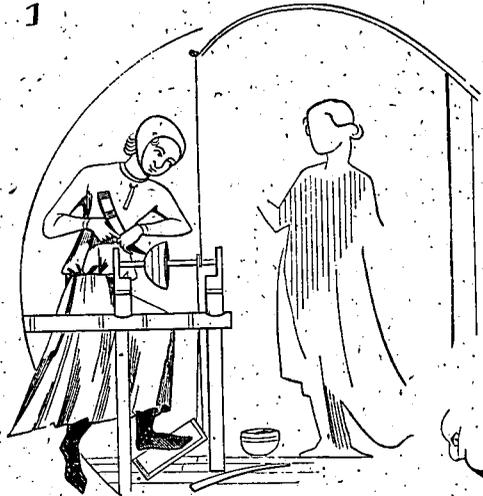
deux barres horizontales jumelles assemblées dans quatre jambages verticaux posant sur des semelles. Entre les jumelles on place deux *poupées* munies de pointes ou percées de trous (*lunettes*), qu'au moyen de clefs on éloigne ou l'on rapproche l'une de l'autre plus ou moins, suivant la dimension de l'objet à tourner. Une corde
